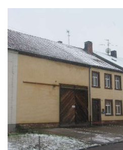
Gebäude vor der Sanierung
